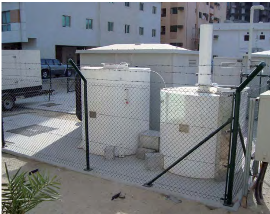
Насосная станция больше не выделяет неприятные запахи.
